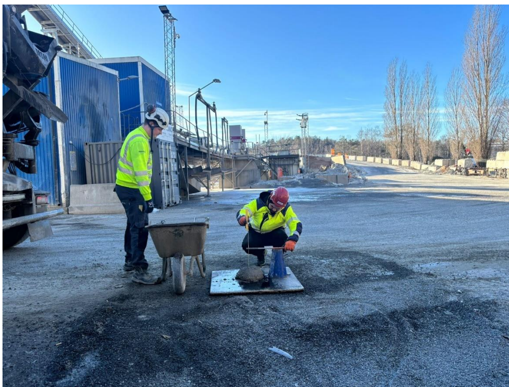
Figur 10 Vikans betonfabrik betongblandning med 70% återvunnet ballast
