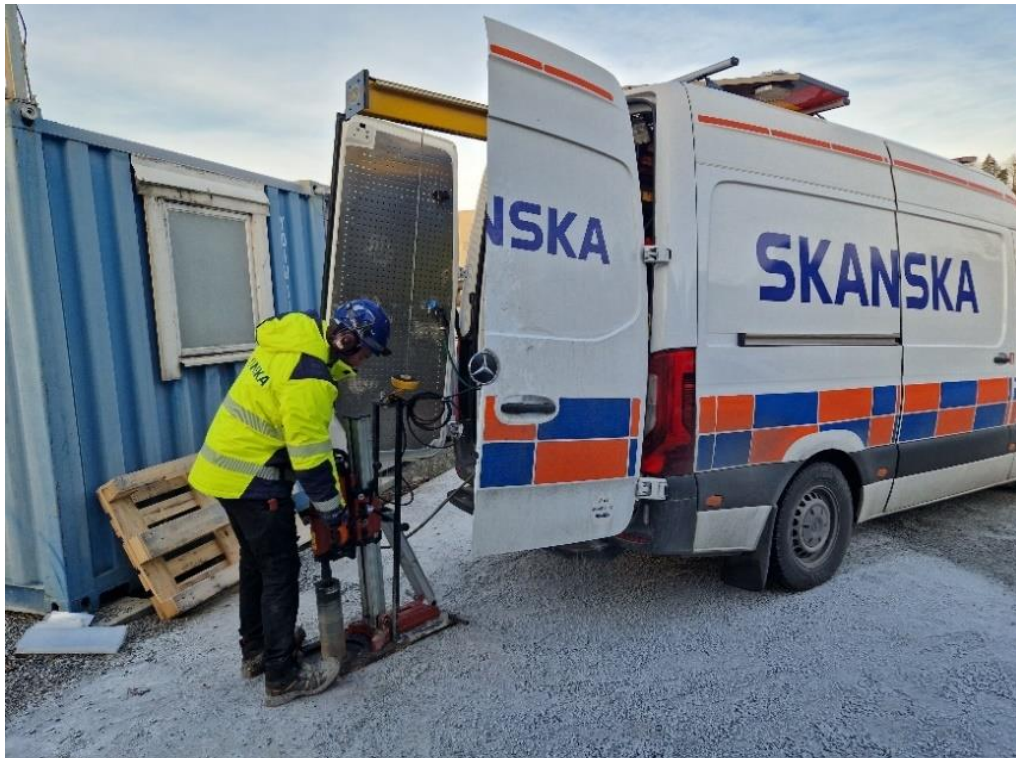
Figur 20 Betongfabrik Betongplatta med 100% återvunnet ballast
