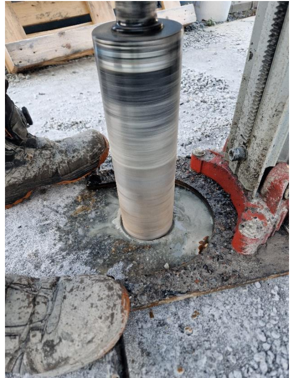
Figur 8 Borring av betongplatta i Farstas betongfabrik 2020 (100% återvunnet ballast)
